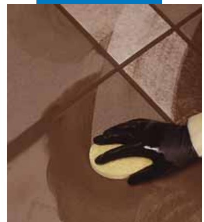
Nettoyage et finition des joints à l'éponge
