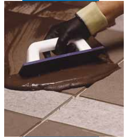
Application d'Ultracolor Plus en sol à la spatule caoutchouc
