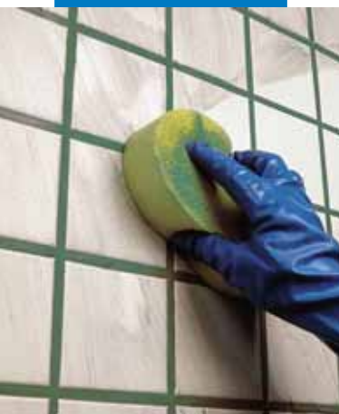
Nettoyage et finition des joints à l'éponge, en mur
